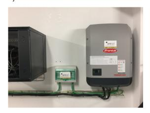
El inversor Fronius Eco sin transformador, con peso ligero y sistema de montaje SnaplNverter permite una instalación sencilla y rápida.
