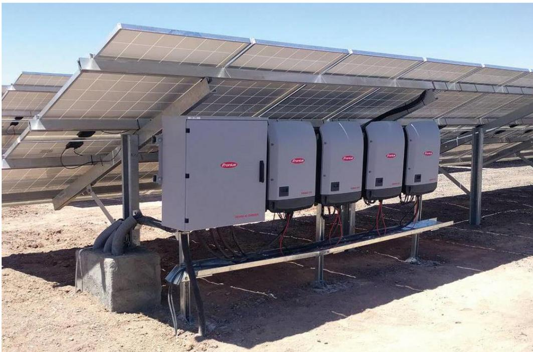
*Figura 3: Disposición grupal de inversores string en una instalación con diseño descentralizado*
