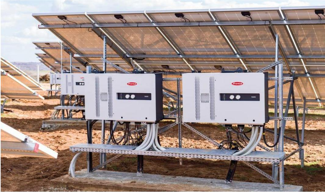
*Figura 7: AC daisy-chaining con Fronius Tauro ECO en disposición grupal descentralizada*
