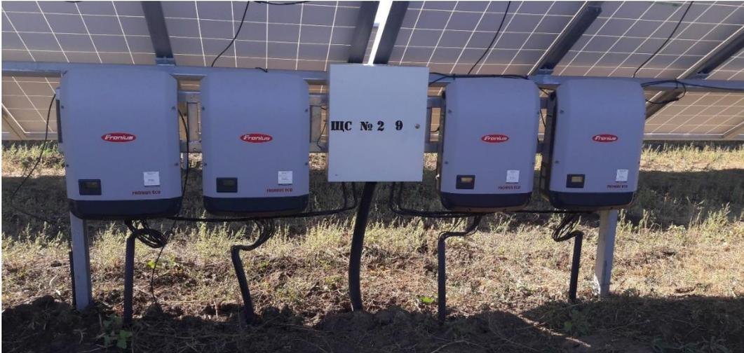
*Figura 10: Ejemplo de agrupación de 4 inversores: Instalación Tokmak (Fuente: Fronius)*
