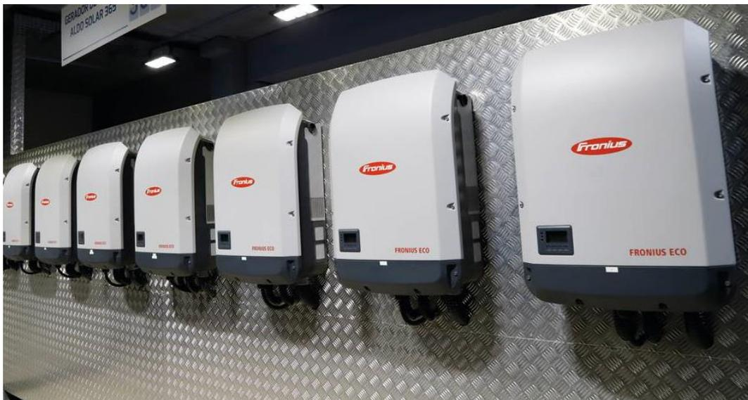
*Figura 5: Disposición central de los inversores string cerca del distribuidor principal*
