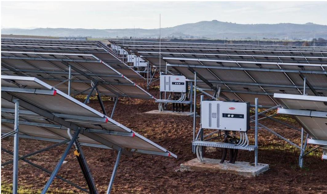
*Figura 2: Disposición individual de inversores string en una instalación con diseño descentralizado*
